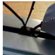
**Lamellen- und Stegbandbefestigung an der Unterschiene**
