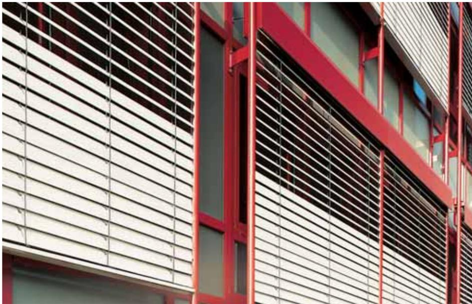
E 80 A6 D mit 52 mm Rundrohrführungsschiene und freitragender Rundbogenblende
